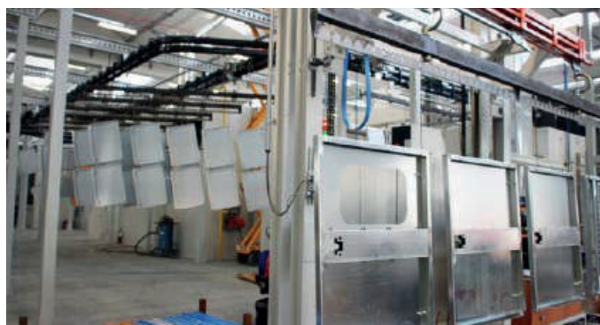
PEINTURE INDUSTRIELLE - INDUSTRIAL PAINTING
